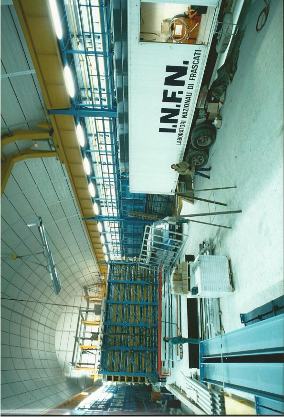
Figura 11: MACRO durante la costruzione del primo supermodulo.
